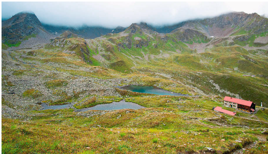
Die Niederelbehütte neben dem Sess-See
