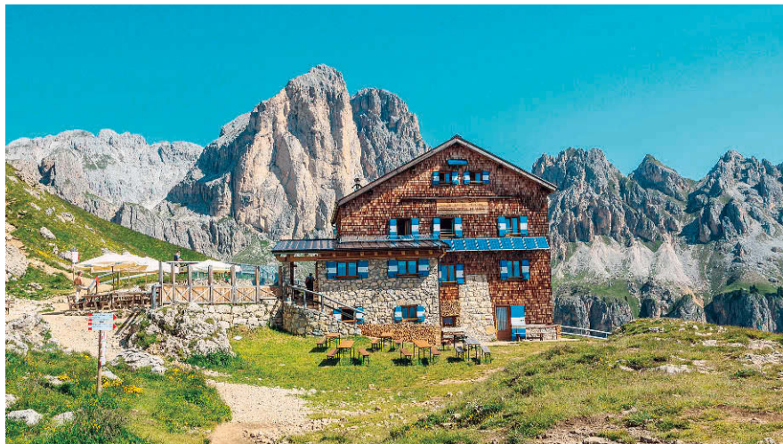
Einen Besuch wert: die Rotwandhütte
